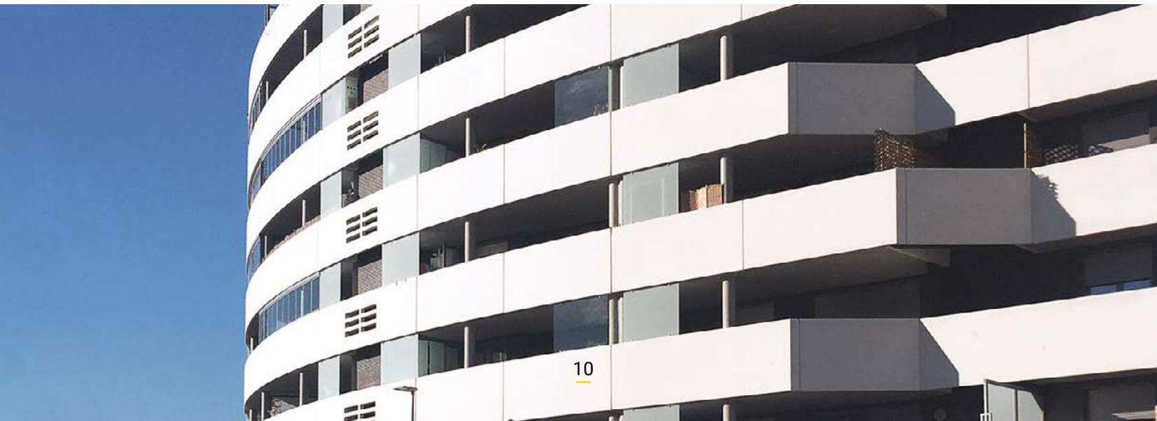
El sistema permite incorporar carpintería de puertas y ventanas directamente en factoría, fijándola a los moldes antes de proyectar el G.R.C. Igualmente permite la realización de los huecos de fachada para que una vez montados los paneles en obra se ensamblen a las carpinterías de forma convencional.
